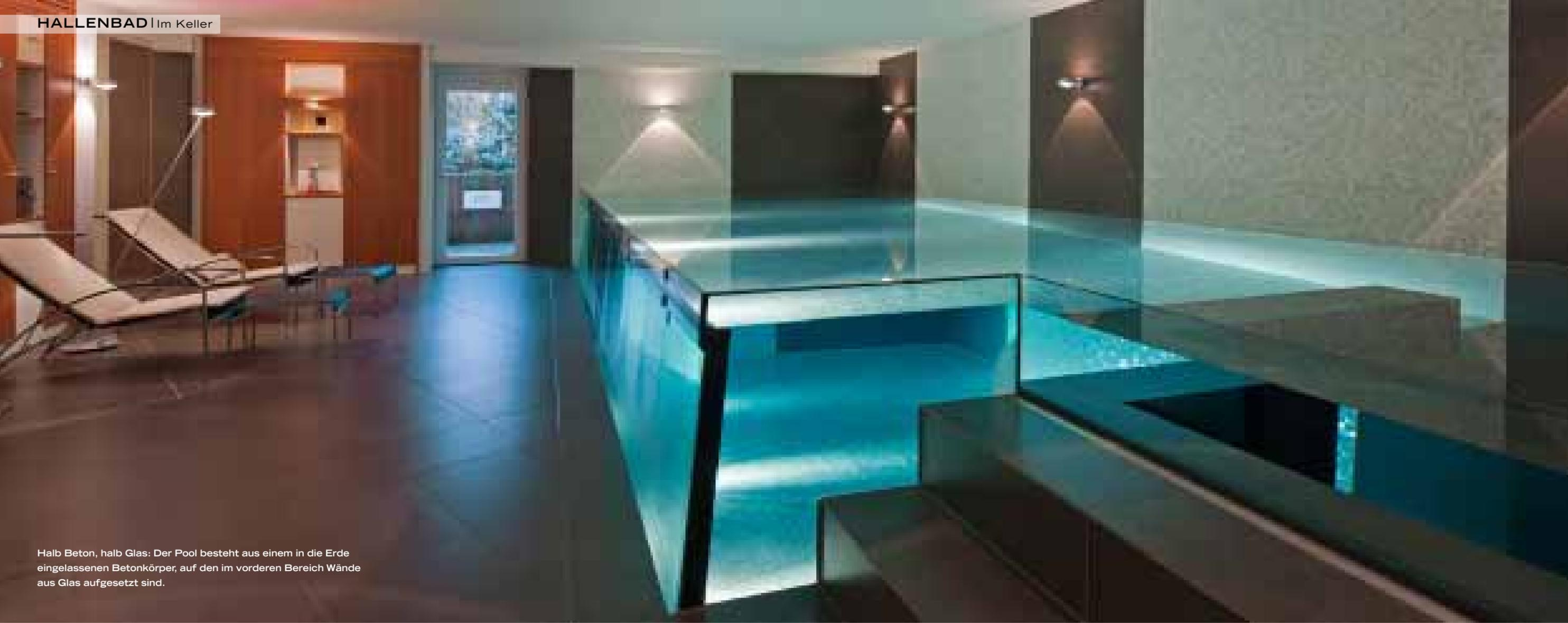
Halb Beton, halb Glas: Der Pool besteht aus einem in die Erde eingelassenen Betonkörper, auf den im vorderen Bereich Wände aus Glas aufgesetzt sind.
