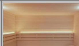
Bankanlage aus Espenholz. Die aus Espe gefertigten Liegen sind stufenförmig, lt. Zeichnung, angeordnet, gerade Vorderkante. Rückenlehnen und Blenden bestehen aus drei gleichen Leisten.
