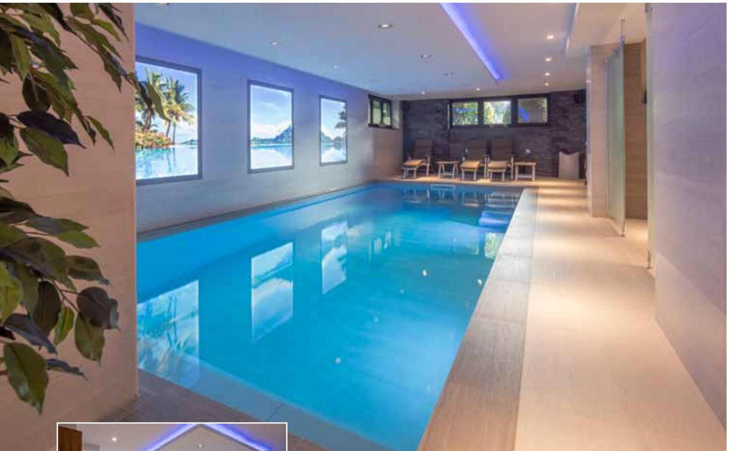
**Nicht mehr wiederzuerkennen: Das Schwimmbecken wurde komplett saniert, mit einer Folie ausgekleidet und dann mit einer Rollladen-Abdeckung, Scheinwerfern und neuen Einbauteilen ausgestattet.**
